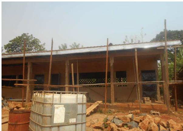
Photo 4 : Bloc de 02 salles modernes en construction
