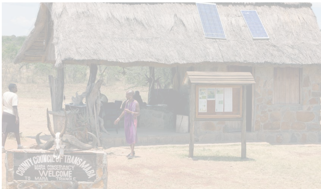
Solar power, Kenya.
