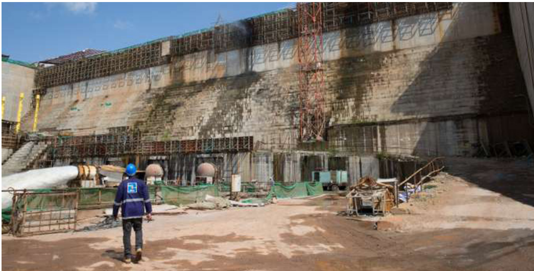
Photo 3 : Site du barrage de Lom-Pangar en chantier
