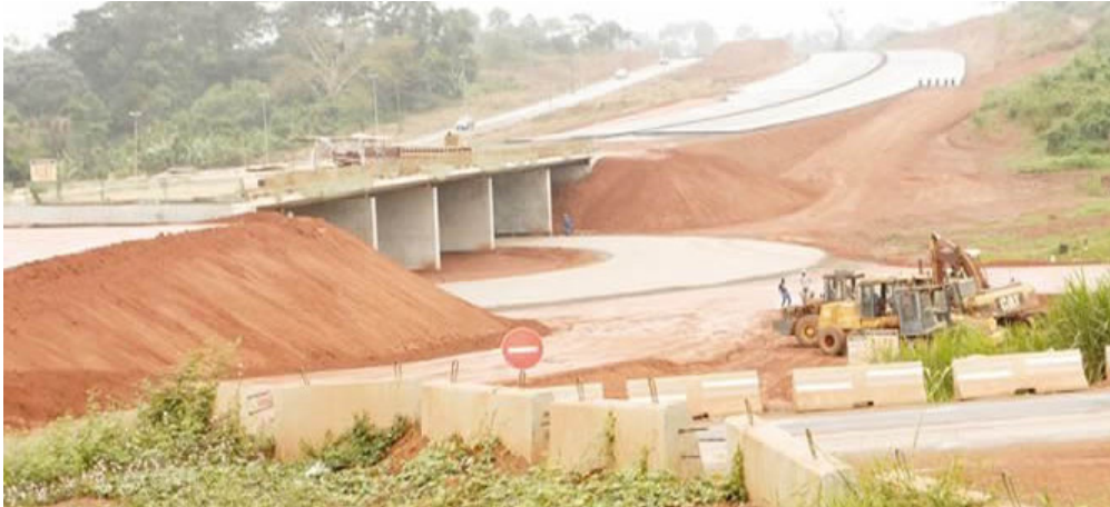
Photo 2 : Echangeur du rond point Aéroport Nsimalen en construction
