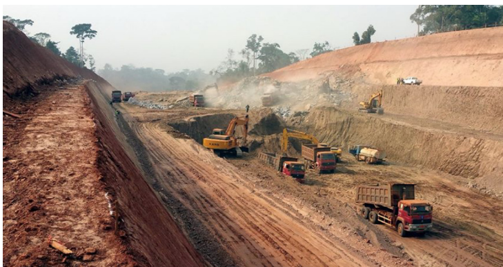
Photo 1 : L'autoroute Yaoundé-Nsimalen en construction
