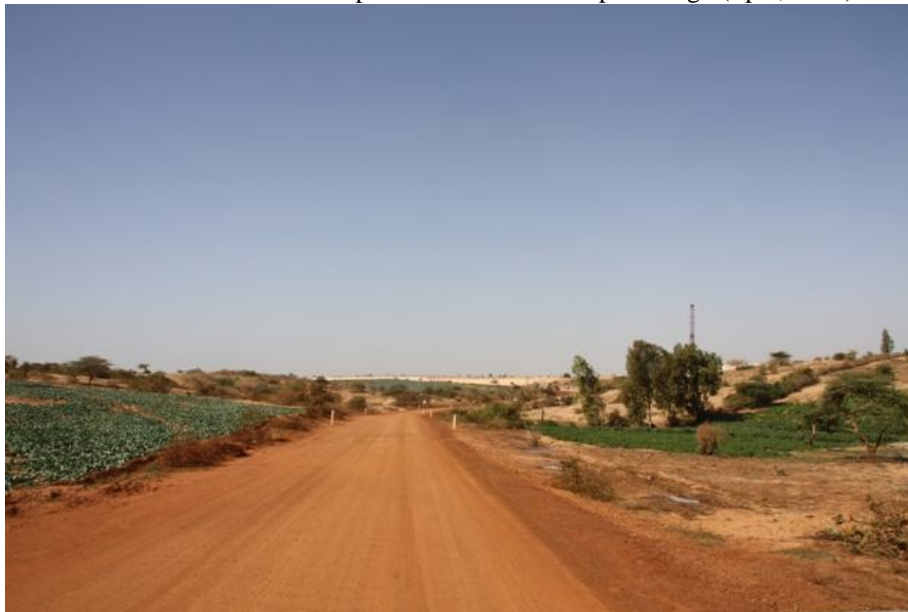
Photo 2: Route construite par GCO sur des champs à Diogo ( Ipar, 2015)
